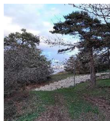
Réalisation des joints du théâtre de verdure par la C.C.R.C.
