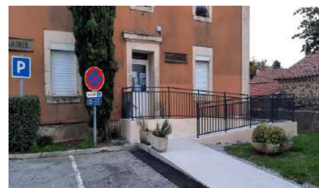
Réalisation de la rampe d'accès à la Médiathèque
