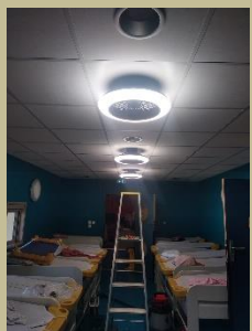
Installation de lumières avec ventilateur intégré dans la salle de sieste à AERIA
