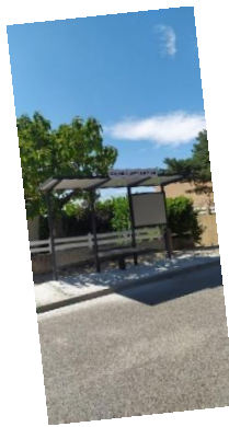
Installation d'un 2 ème abri bus à la sortie du village – Aout 2024
